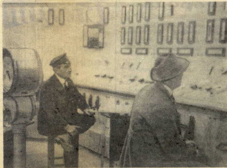
Ночь на 17 ноября 1926 года. Сейчас волховские генераторы должны дать первые киловатт-часы. У пульты — главный инженер строительства Генрих Осипович Графтио.
