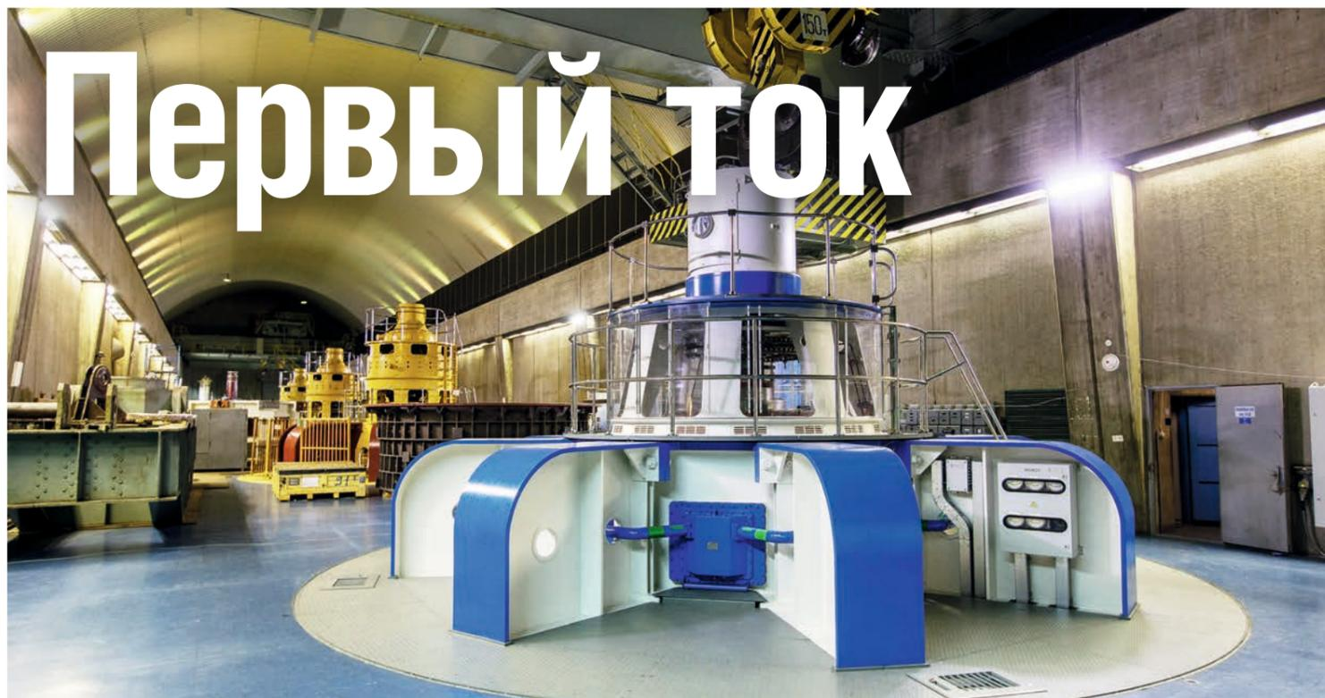
**Первый модернизированный гидроагрегат Верхне-Тулумской ГЭС готов к работе. В марте завершились комплексные испытания оборудования.**
