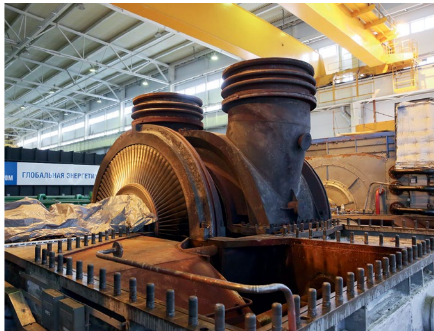
Большой объем работ выполнен на ПГУ-450: произведен ремонт цилиндра низкого давления паровой турбины, выполнены работы по увеличению надежности турбогенераторов газовых турбин, а также рекомендации по результатам эксплуатационного мониторинга. Работы по установке уплотнительного шнура в горизонтальный разъем цилиндра низкого давления паровой турбины обеспечат улучшение эксплуатационных и экономических показателей энергоблока
