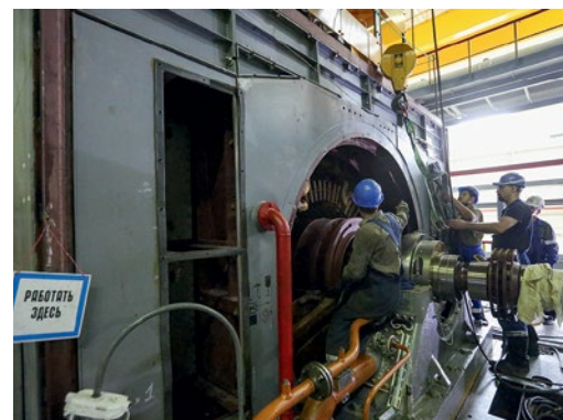
Большой объем работ выполнен на ПГУ-450: произведен ремонт цилиндра низкого давления паровой турбины, выполнены работы по увеличению надежности турбогенераторов газовых турбин, а также рекомендации по результатам эксплуатационного мониторинга. Работы по установке уплотнительного шнура в горизонтальный разъем цилиндра низкого давления паровой турбины обеспечат улучшение эксплуатационных и экономических показателей энергоблока
