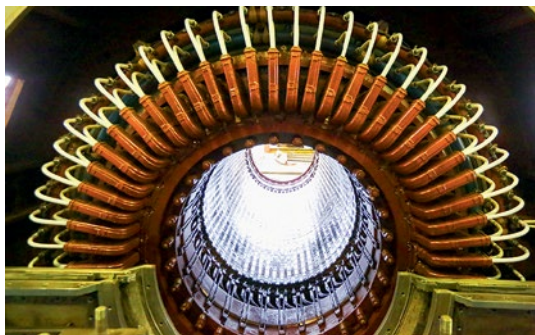
Турбогенератор после восстановления и ремонта системы охлаждения статора
