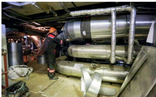
Ремонт тепловой изоляции способствует уменьшению тепловых потерь и обеспечивает безопасность обслуживающего персонала
