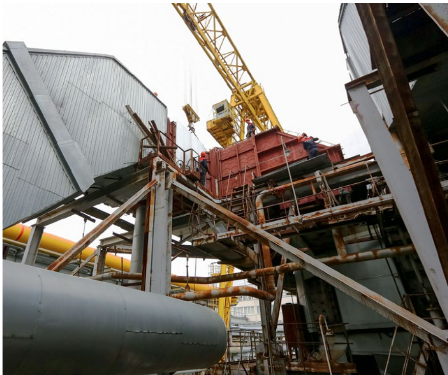
Монтаж газозовдуховодов котлоагрегата
