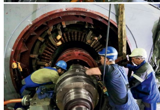
Работы по повышению эксплуатационной надежности турбогенераторов газовых турбин
