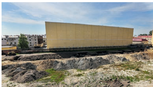
Строительная площадка ЭС-2 Центральной ТЭЦ
