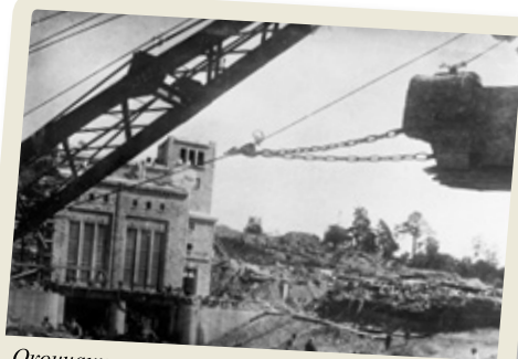
Окончание строительства первой очереди ГЭС. 1928–1929 гг.
