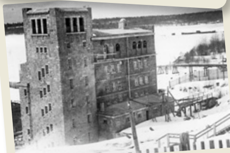
Первая очередь ГЭС. 1931 г.
