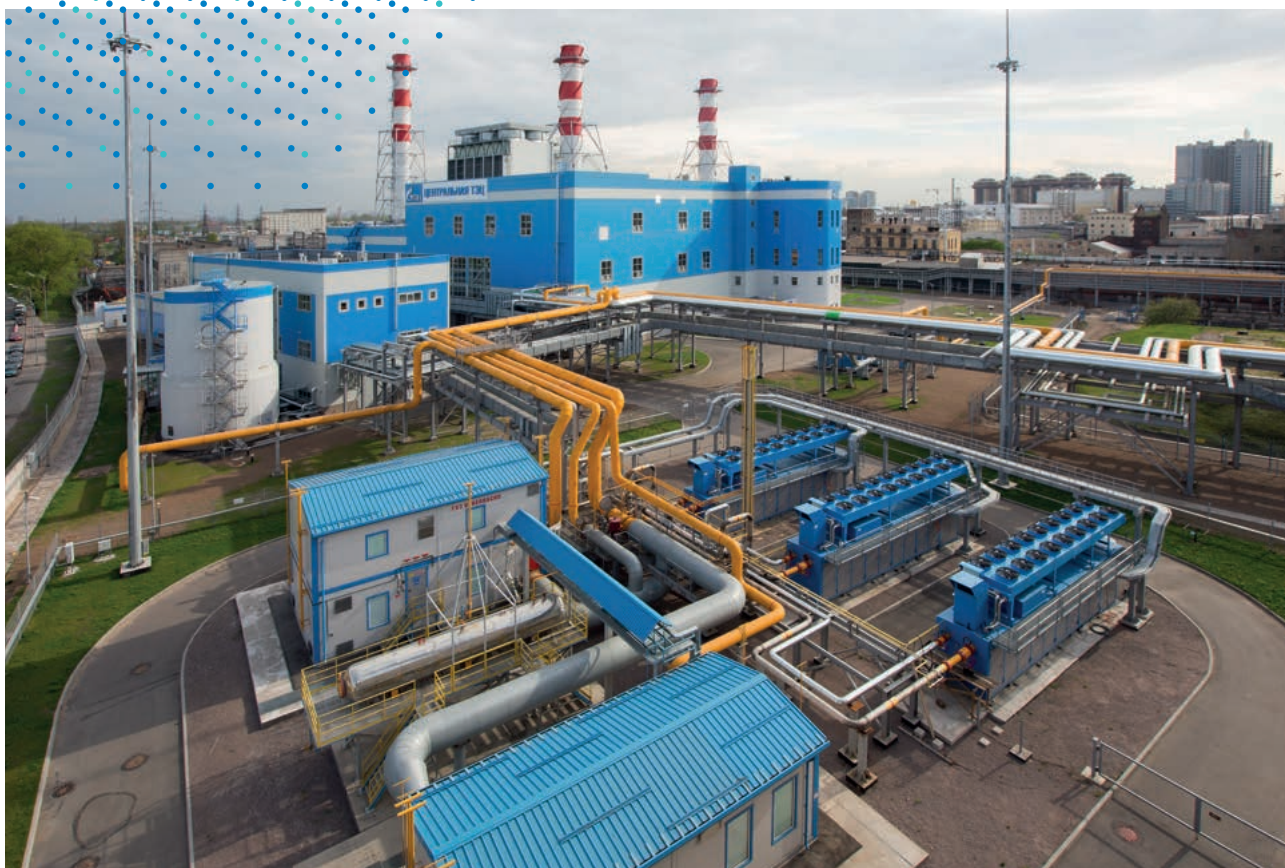
ЭС-1 Центральной ТЭЦ
