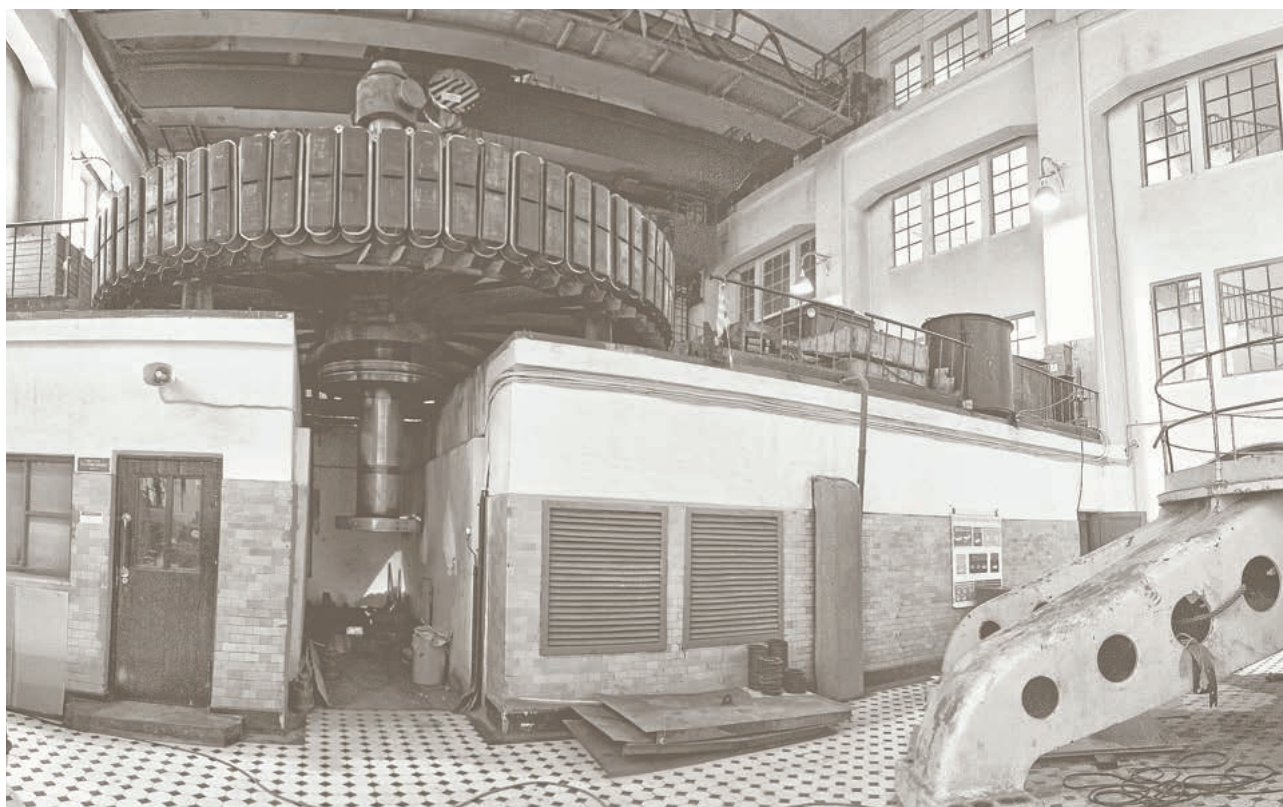
Волховская ГЭС. Замена рабочего колеса
