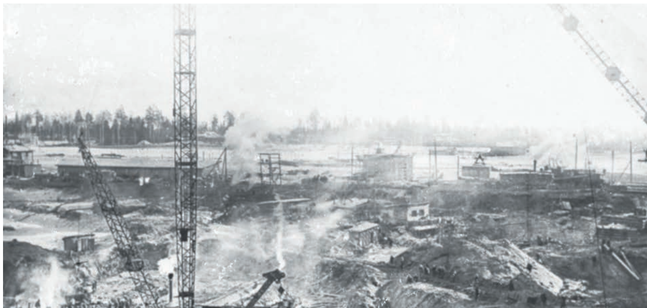
Строительство Нижне-Суйской ГЭС, 30-ые годы
